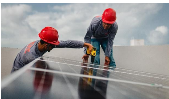
Figura 8: fixação de painéis fotovoltaicos.
