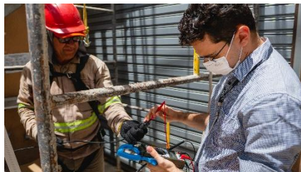
Figura 7: Teste de circuito aberto.
